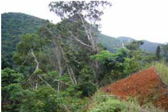
写真 10．野底林道の崩壊 2
