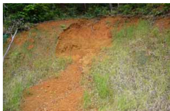
写真 11．野底林道の崩壊 3
