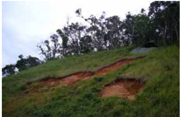
写真 9．野底林道の崩壊 1
